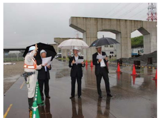
道路建設の現状説明を受ける堤会頭ら
